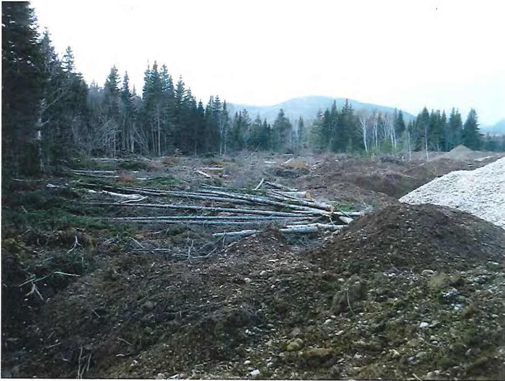
Image 31: Zone déboisée derrière les tas d'agrégats lavés
