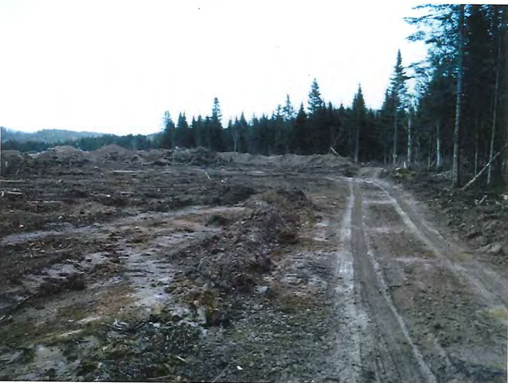
Image 15: chemin en bordure de la zone d'exploitation
